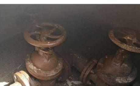
Figura 1 - Valvole di sezionamento rete di distribuzione Centro Storico
